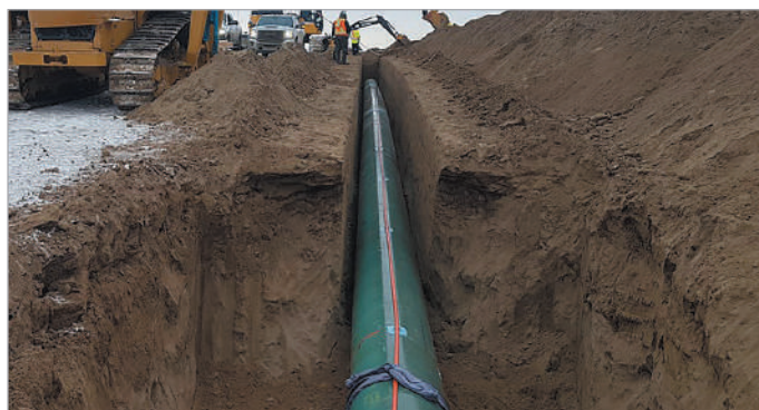
Рисунок 15. Укладка трубопровода с закреплённым оптоволоконным кабелем чувствительного элемента (оранжевый). Фото из журнала Pipeline Technology Journal #2/2021.
